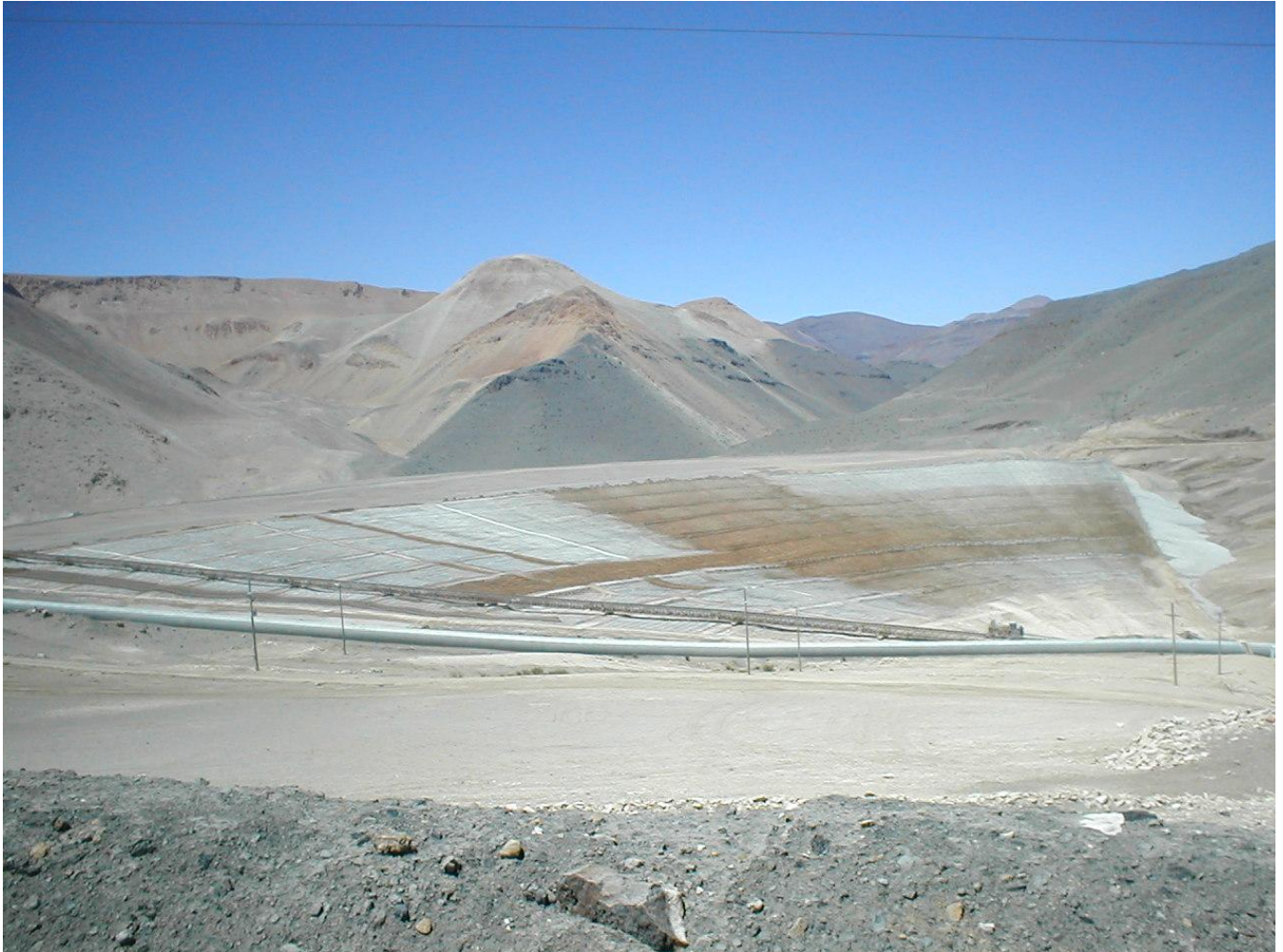
Figura N° 60: Depósito de Relaves Filtrados La Coipa
