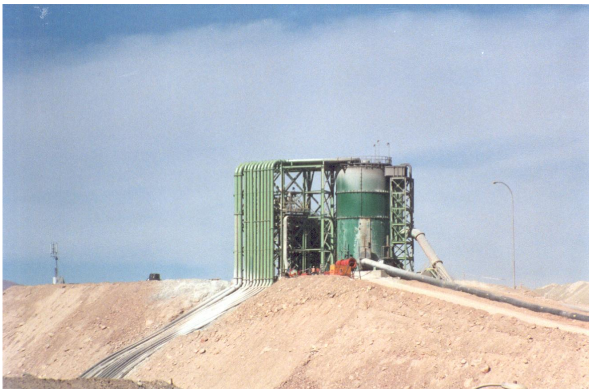
Figura 35: Estanque “Amelunxen” para disposición de relaves en Los Colorados
