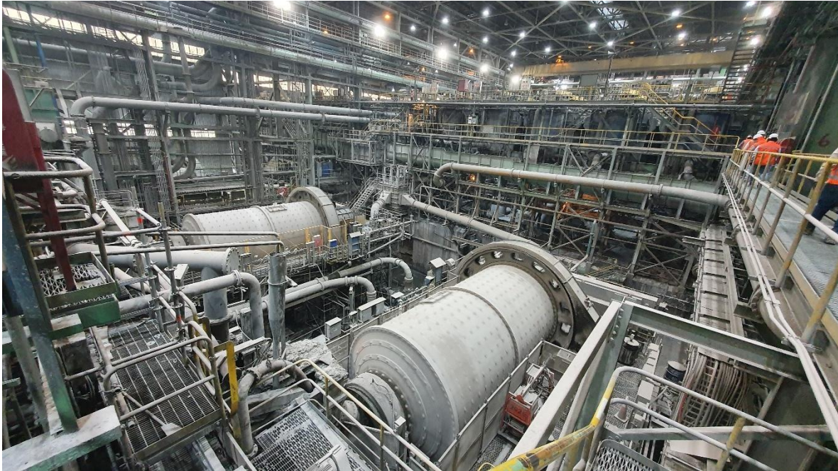
Figura 38: Fotografía de los dos Molinos de Remolienda Fase original Los Colorados
